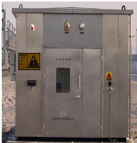
危险废物暂存间标识牌
