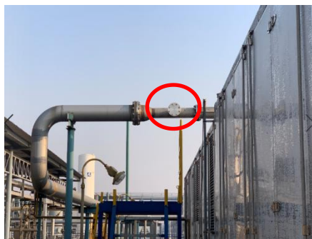
油气处理回收装置进口采样口
